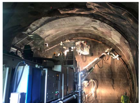
写真-3 本坑特殊区間の施工状況
