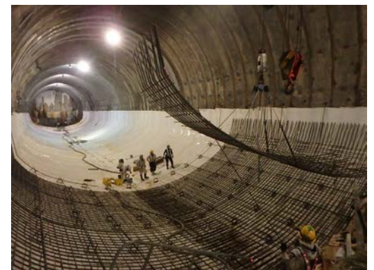
写真-2 ユニット鉄筋設置状況
