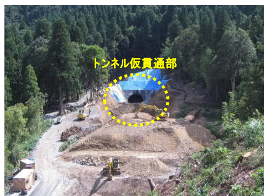
写真1 事前地山改良部全景
