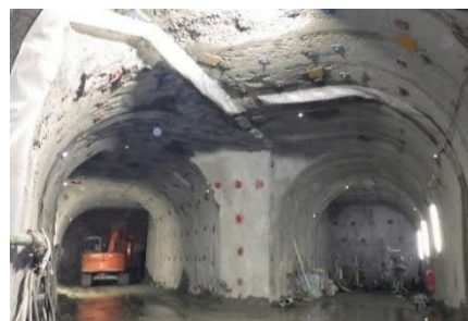
写真-2 交差部施工状況
