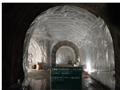
写真-3 交差部・屈曲部の湧水対策
