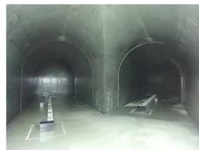
写真-5 交差部完成写真
