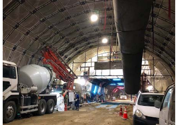
写真-1 覆工コンクリートの打込み状況
