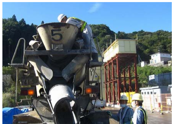
写真-2 VSP 後添加による流動化コンクリートの製造
