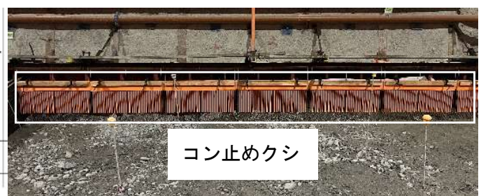
写真-2 型枠設置状況
