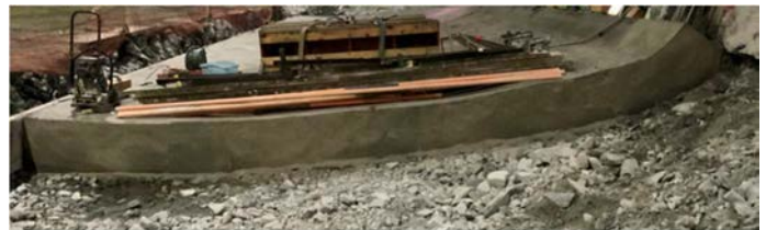
写真-5 脱型後の断面形状
