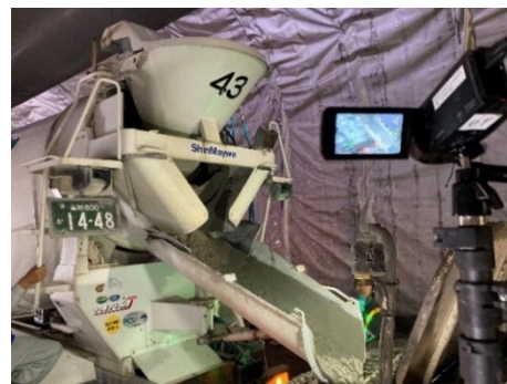
写真-2 トンネル覆工コンクリートへの受入れ管理システムの適用状況
