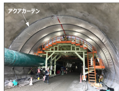
写真-3 浸水養生工法による養生
