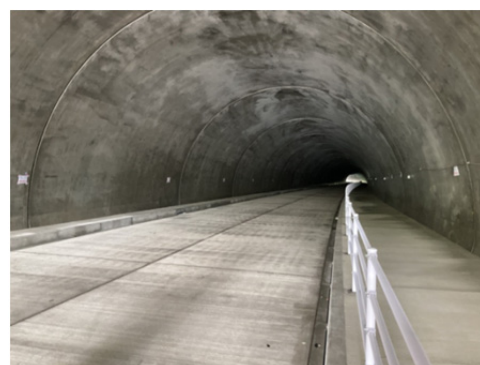
写真-4 覆工コンクリートの外観状況
