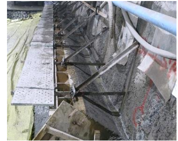
写真1 打継ぎ目構造
