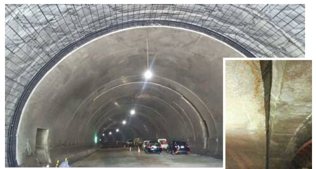
写真1 設置完了およびコンクリート打設後の状況
