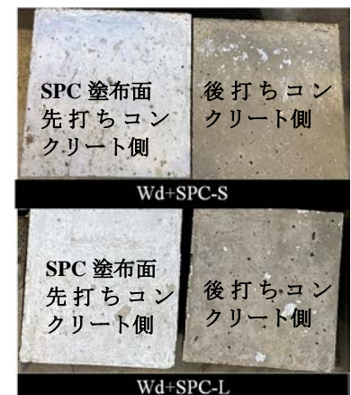
写真-3 試験後の目地面
