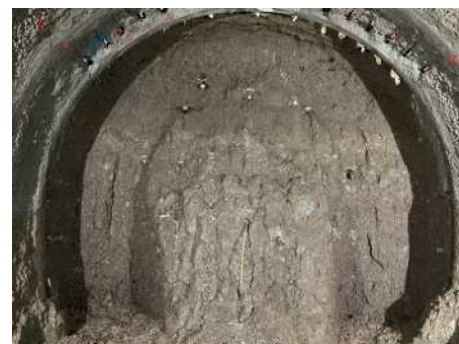
写真2 切羽状況 (Pt1層)
