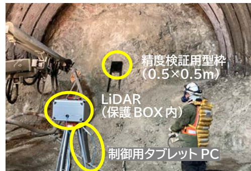
図-3 現場での精度検証試験状況
