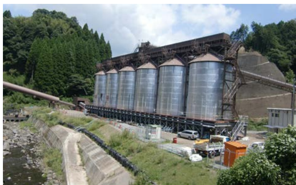
写真 - 2 地上化した引き出しベルコン
