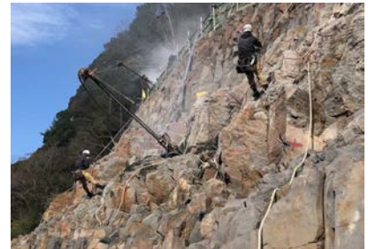
写真-1 SD 工法施工状況
