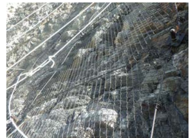
写真-2 施工箇所近景
