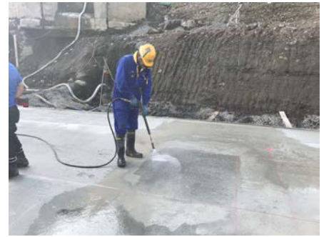
写真-1 グリーンカット施工状況
