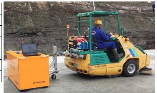
写真-2 グリーンカット判定状況
