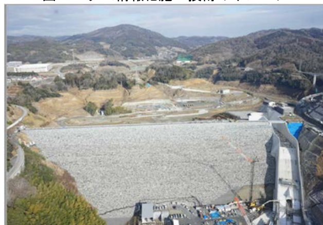
写真-1 安威川ダム
