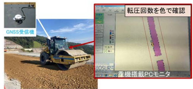
図-3 転圧管理システム
