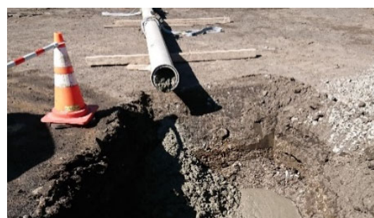
写真-3 Gmax80mm コンクリート 30m 圧送
