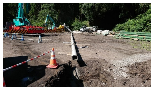
写真-2 30m 圧送試験状況
