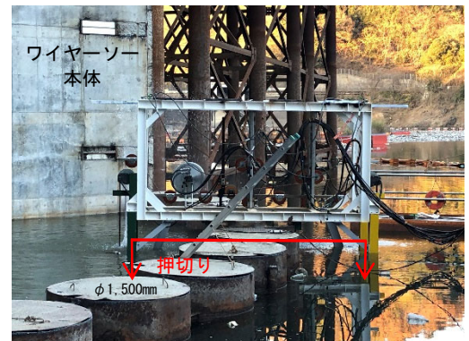
写真-4 ワイヤソー工法による鉛直押切り施工状況
