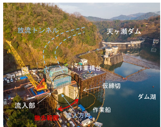
写真-2 全景写真
