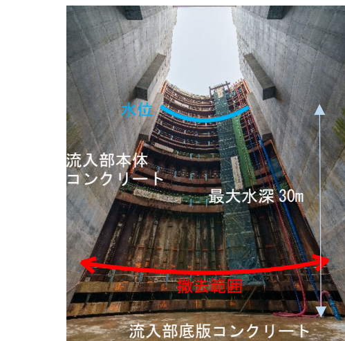
写真-1 鋼管矢板仮締切内全景
