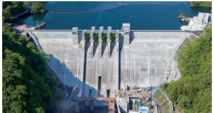
写真-1 ハッ場ダム全景
