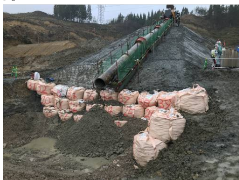
写真-2 土砂搬送状況
