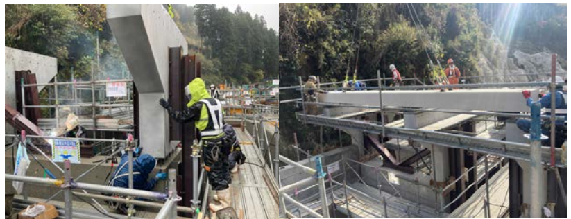
図-6 プレキャスト設置状況(左:柱, 右:スラブ)
