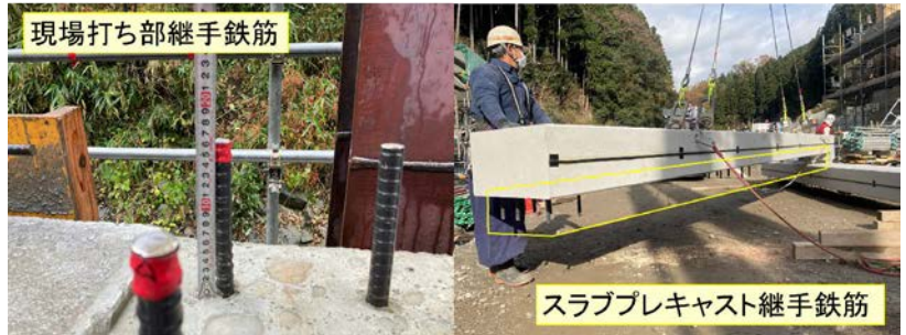
図-5 継手鉄筋配置状況
