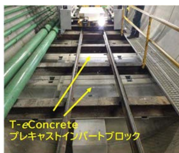
写真-3 現場設置状況
