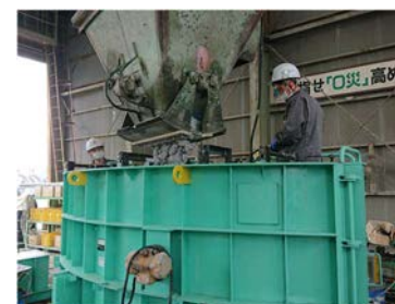
写真-1 打込み状況
