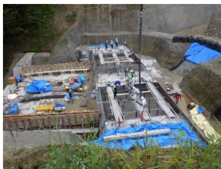
写真-1 調整池堰堤でのコンクリート打設
