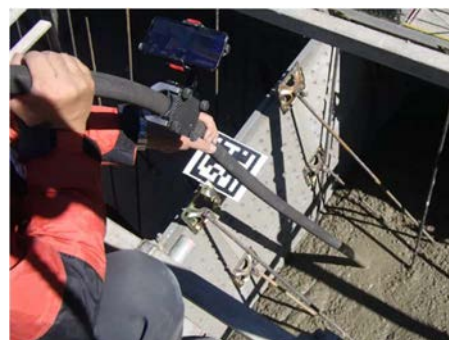
写真-2 コンクリート締固め実証実験
