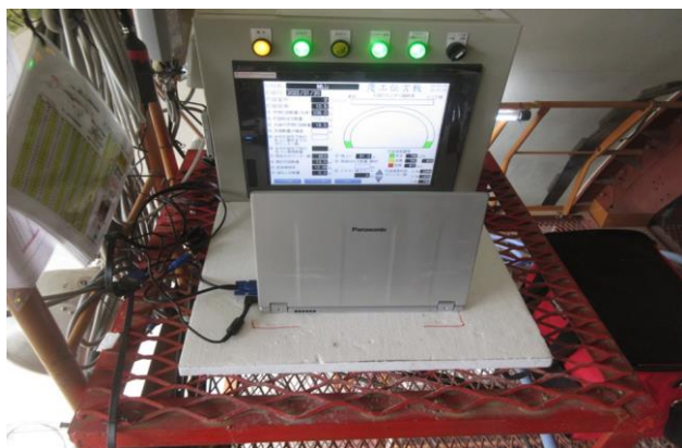
写真-2 打設中の覆工伝言板モニター
