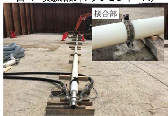
写真-2 特殊樹脂製配管使用状況
