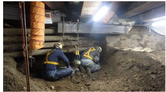
写真-1 狭隘部での人力掘削作業
