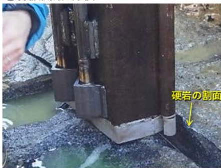
①打設開始3分後
