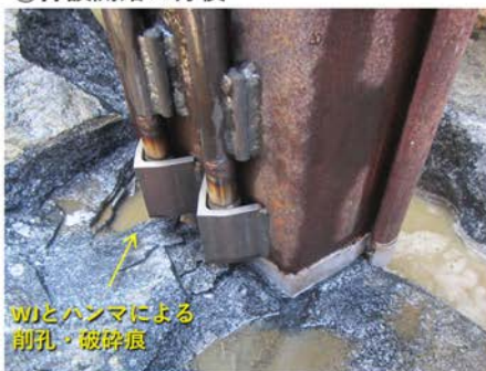
②打設開始13分後
