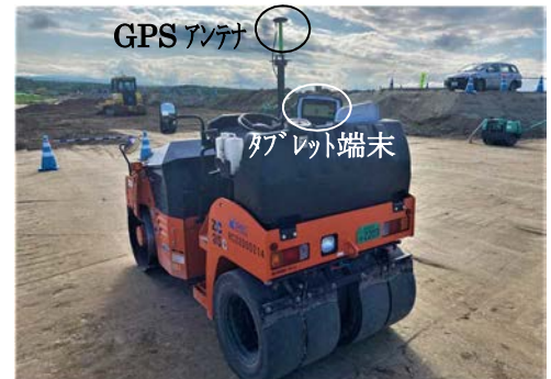
図-1 GNSS 管理を装備したローラー
