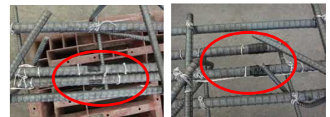
写真-1~2 継手結束(左)と未結束(右)
