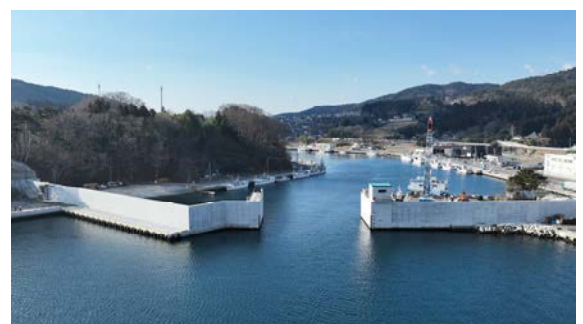
写真-3 海上防潮堤全景
