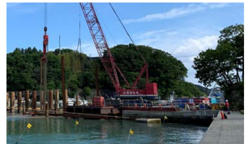
写真-1 鋼管矢板打設状況
