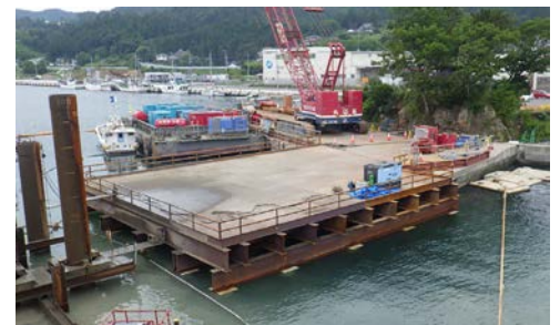
写真-2 仮棧橋 (Sqc ピア工法)
