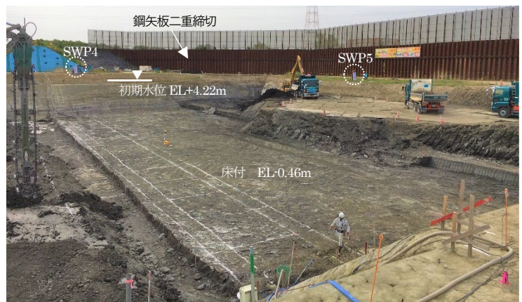
写真1 ドライワーク状況（五六川樋門床付時、地盤改良前）
