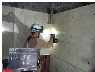
写真-2 パネル設置状況
