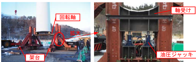
図 1 建て起こし装置の構造
