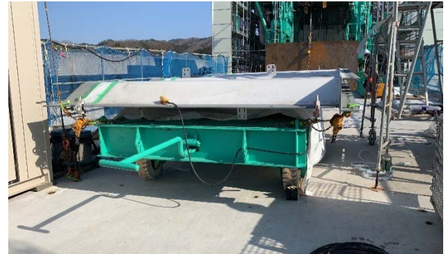
写真-1 波形鋼板運搬台車
