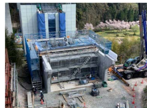
写真-4 側径間先行施工
