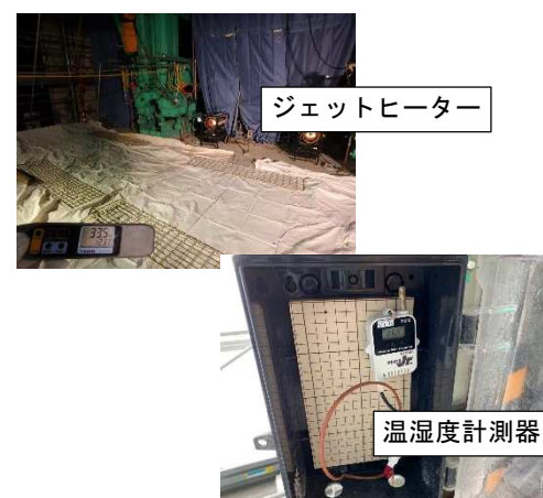
写真-6 コンクリート打設状況
