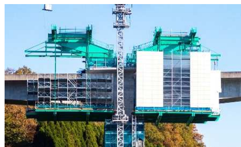
写真 - 1 大型移動作業車
