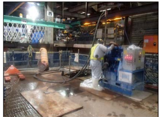
写真-2 地盤改良工（高圧噴射攪拌）
