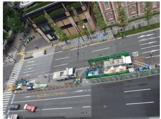
写真-1 地盤改良工（高圧噴射攪拌）地上プラント
