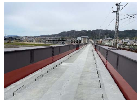
写真-4 床版完成写真
