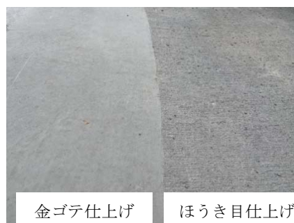
写真-3 コンクリート表面
