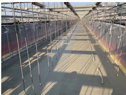
写真-2 鋼繊維コンクリート打設完了
