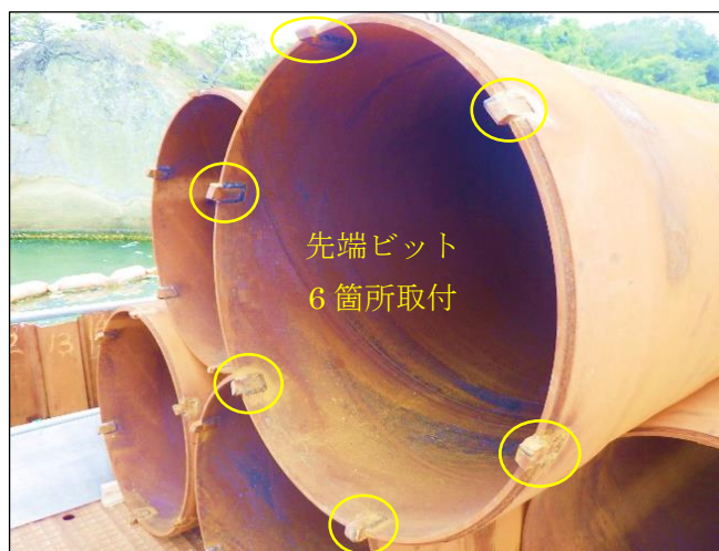
図-5 先端ビット加工
