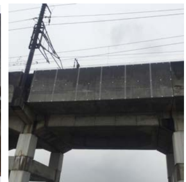
写真-7 施工完了
