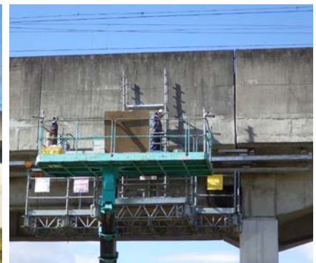
写真-5 クサビ式足場の設置状況
