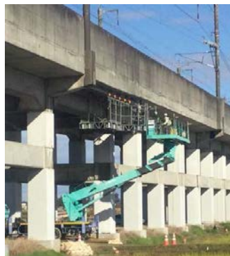
写真-4 作業床設置完了
