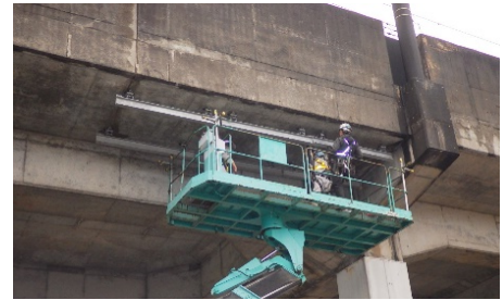
写真-3 走行レールの取付け状況
