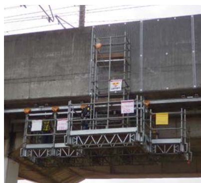
写真-6 ネット張り状況
