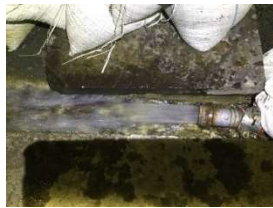
写真-5 地下水の排水
