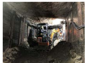
写真-6 横坑掘削
