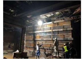
写真-7 ライナープレート（外側）
