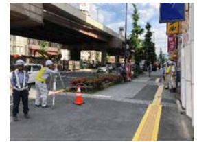
写真-9 路面変状測定
