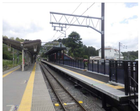
写真-1 工事桁撤去・軌道復旧完了
