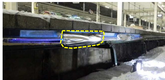
写真-3 アルミシート設置状況
