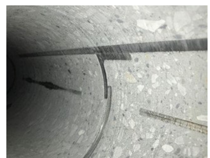
写真-3 模擬鉄骨部充填確認
