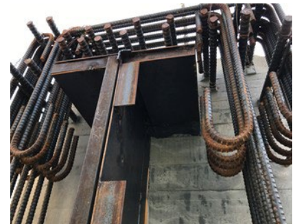
写真-2 モックアップ妻型枠部充填確認
