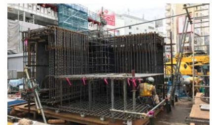
写真-1 試験体の鉄骨・鉄筋組立状況
