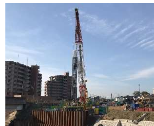
写真-3 鉄筋かご建込状況
