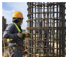
写真-1 モルタル充填
