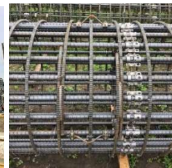
写真-2 無溶接金具設置
