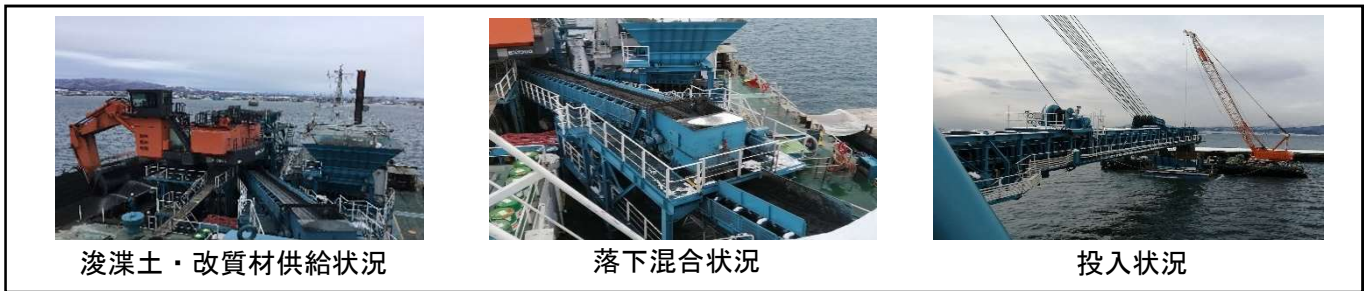
写真-3 カルシア落下混合施工状況
