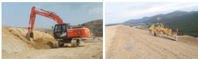
写真-1 ICT バックホウ による法面整形
