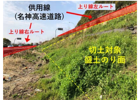
図1 切土対象斜面の状況
