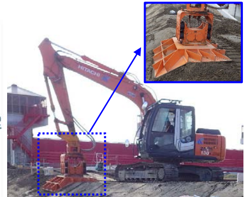
写真-2 締固め状況
