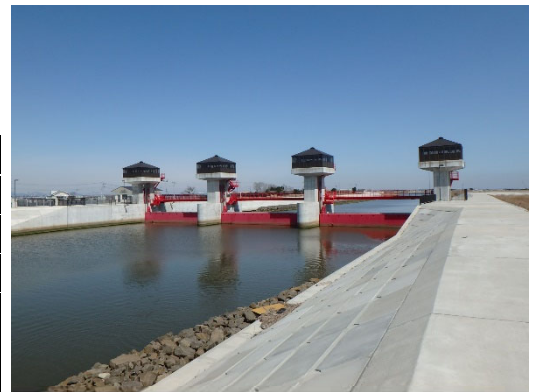
写真-1 防潮水門全景
