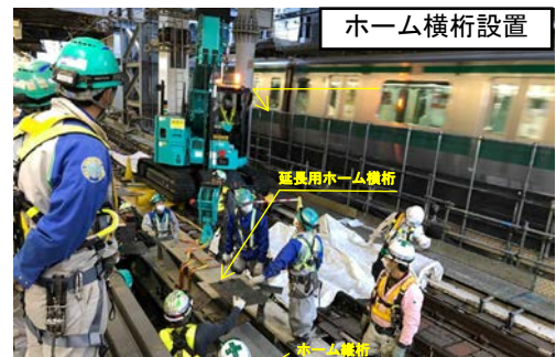
図-5 切換当日のホーム桁引出し施工手順図と施工状況写真
