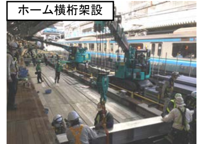
図-3 工事桁撤去部施工状況写真
