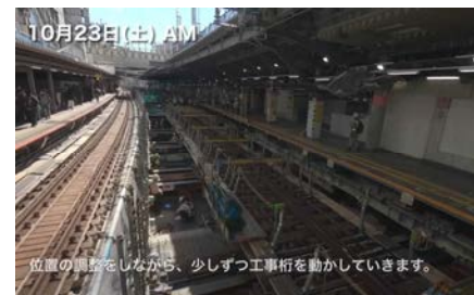
(b) 工事桁移動開始
