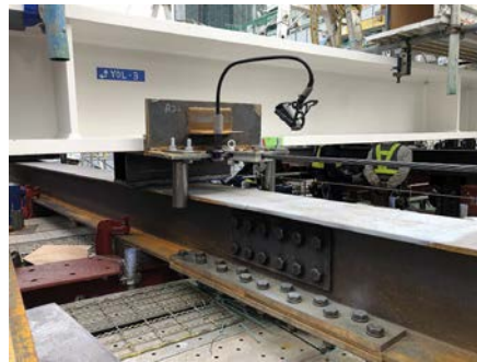
(b) スライド桁および横引き架台
