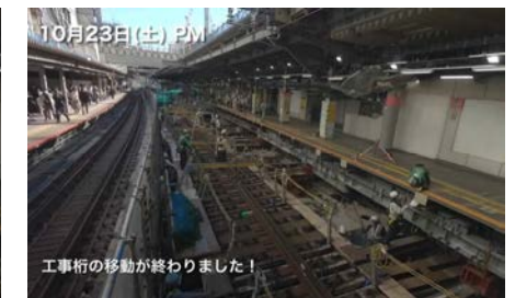
(c) 工事桁移動完了
