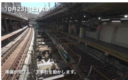
(a) スライド桁を設置
